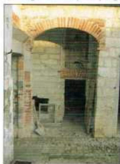
Particolare di edilizia rurale alla Cascina Valpane
