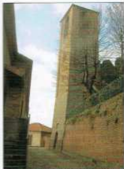
Una strada divide il campanile dal corpo della chiesa
