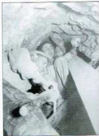
Puntellamento in una finestra del banco di marna
