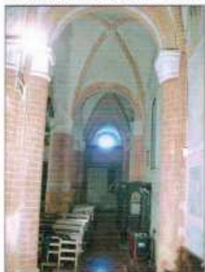
Colonne e volte a crociera nella navata laterale sinistra
