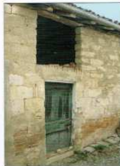
Edificio in pietra da cantoni
