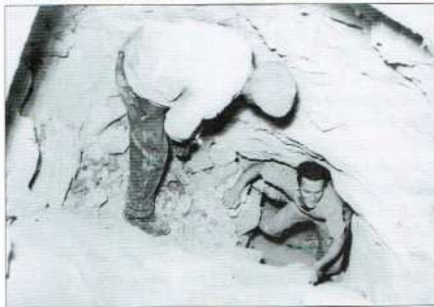
Apertura di una "finestra"
