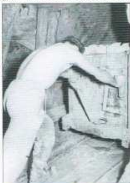
Galleria di carreggio della marna
