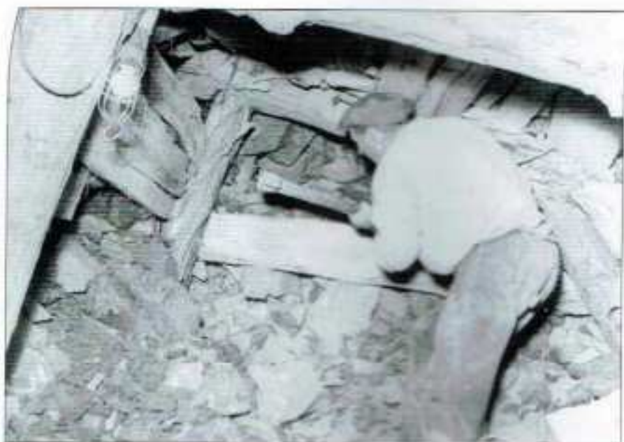
Franamento e recupero del tetto della galleria
