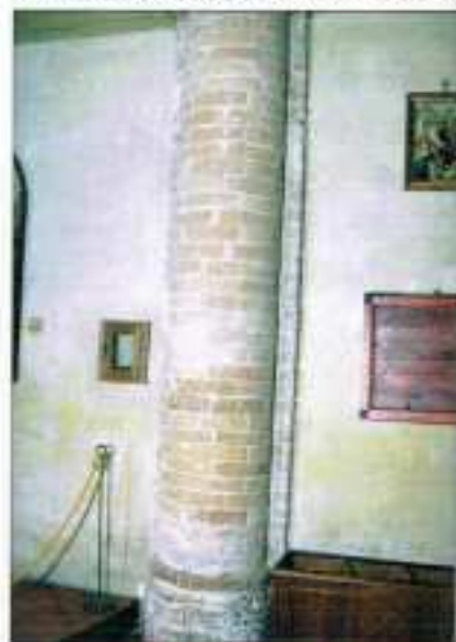
Contrafforte interno in cotto
