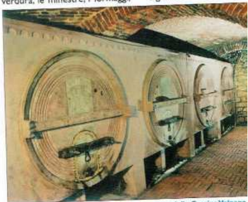
Vasche di fermentazione in cemento della Cascina Valpane
