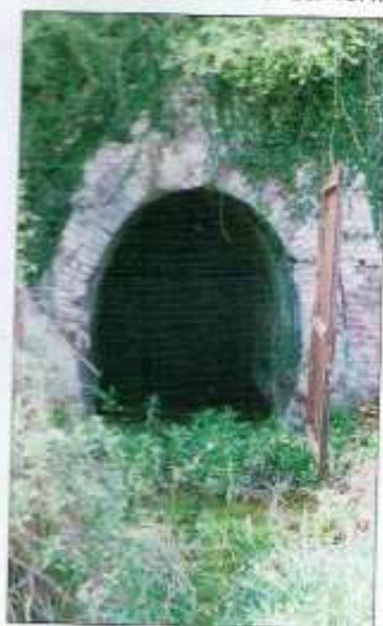
L'entrata attuale della galleria Laurenta
